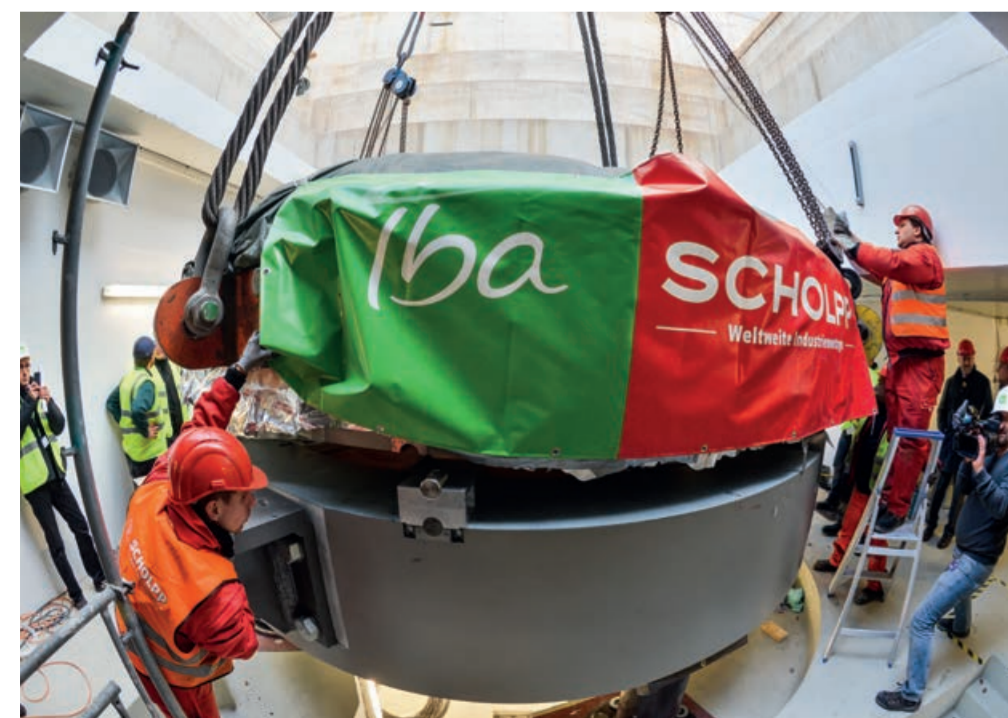
Nach Einbringung der über 330 Tonnen schweren Komponenten übernahm das SCHOLPP-Team auch deren mechanische und elektrische Montage und Einmessung.
