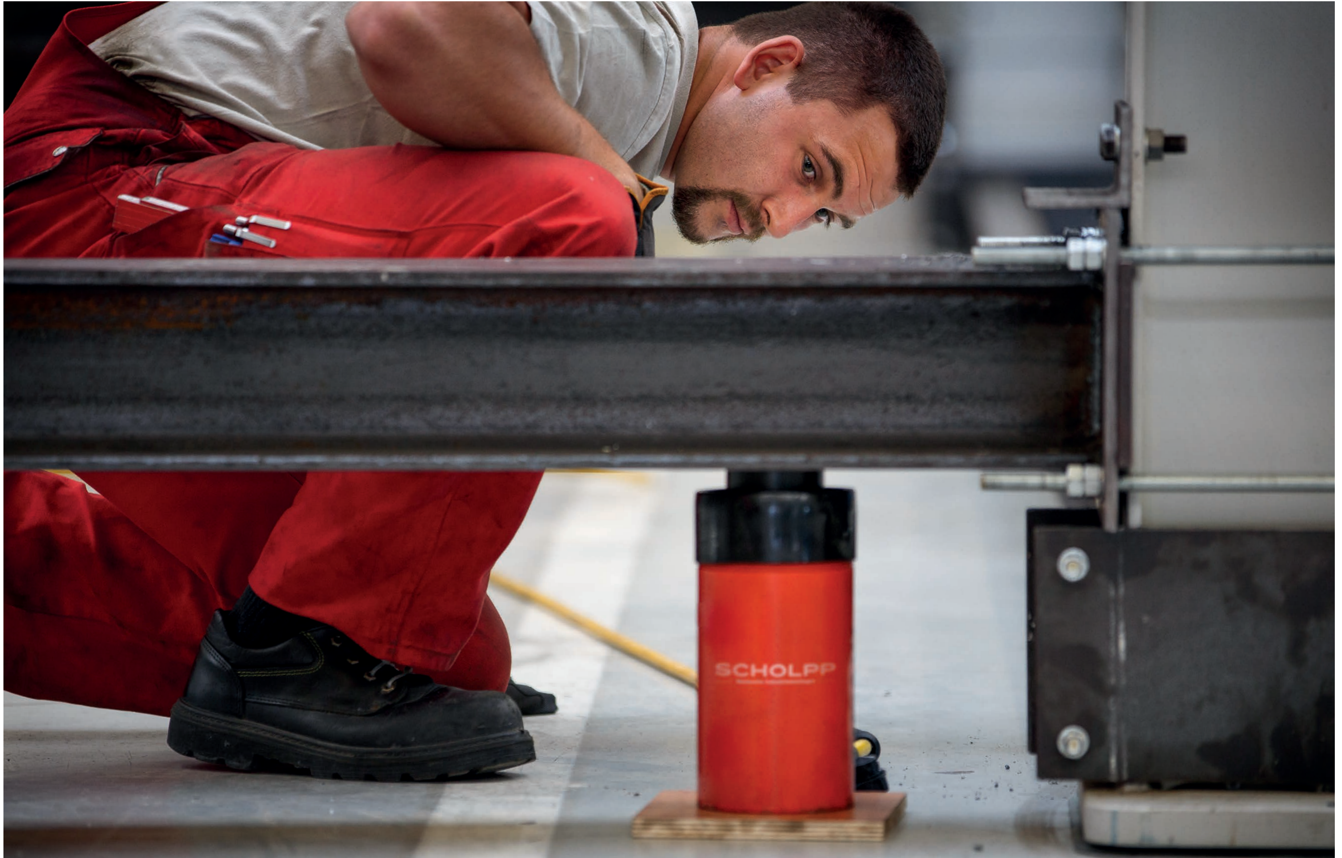
Präzise und kreativ: Mit Hilfe einer Spezial-Aussteifung konnten die SCHOLPP-Monteur die Hebeanlagen von Hymer in Bad Waldsee als Komplettstück gleichmäßig anheben und verschieben.
