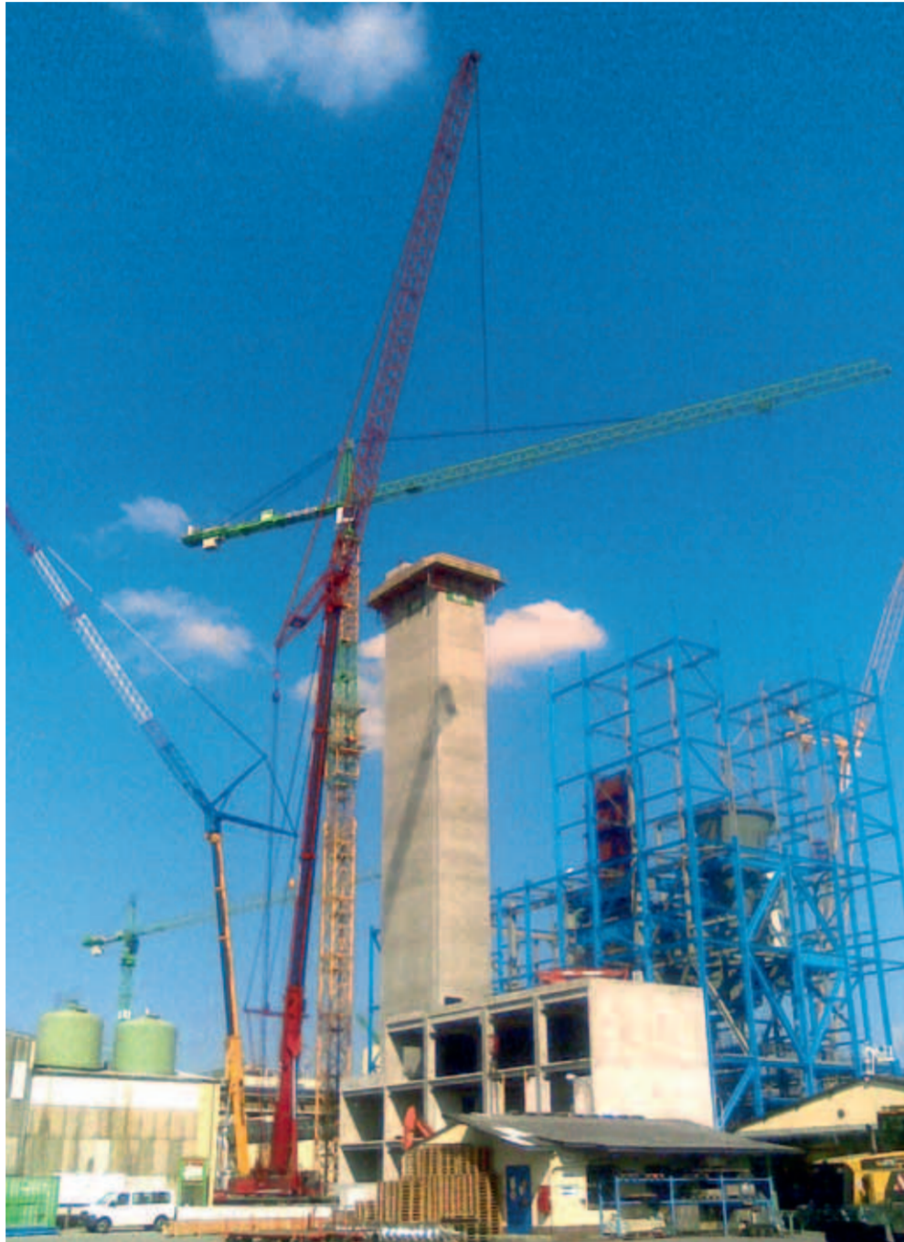
SCHOLPP richtet bei Stora Enso Kraftwerksbaustelle ein und begleitet den Baufortschritt mit passendem Equipment in jeder Dimension
