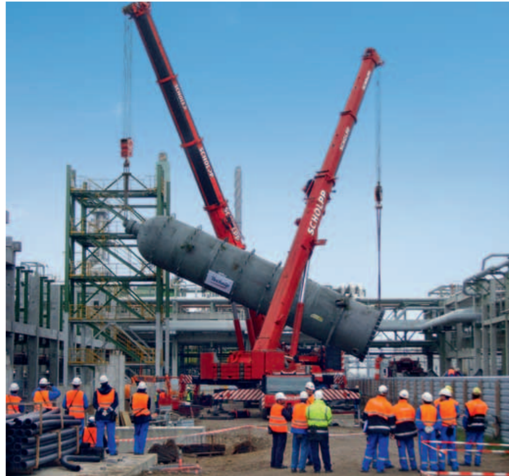
Aufrichten des Reaktors mit Tandemhub der SCHOLPP-Kranen S-GK 700 und S-GK 300
