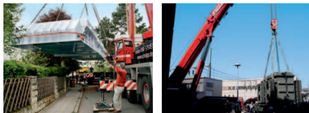
Oben links: Ein neues Dach für den Brettener Pfeiferturm. Oben Mitte: Umzug einer 30 Tonnen schweren Presse. Darunter: Einbringung eines 22 Tonnen schweren Heizkessels. Oben rechts: Schwerlastkai bei SCHOLPP in Stuttgart: Verladung eines 120 Tonnen schweren Laufringes vom Schiff auf ein Transportfahrzeug. Mitte links: Der alte Steg muss weichen: Über Nacht bekommt die Bahn in Lahr einen neuen Steg. Unten links: Ein Pool schwebt an seinen Bestimmungsort. Unten Mitte: Verladung eines Transformators. Unten rechts: Mehrere SCHOLPP-Krane beim Abbau des Volksfestes
