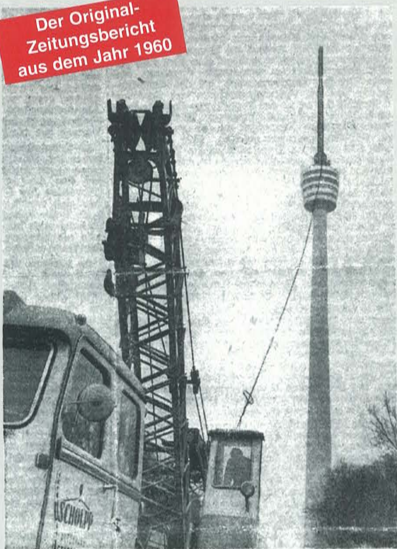
Eine 400 Meter lange Stahltrasse läuft hinauf zum Antennenmast.
