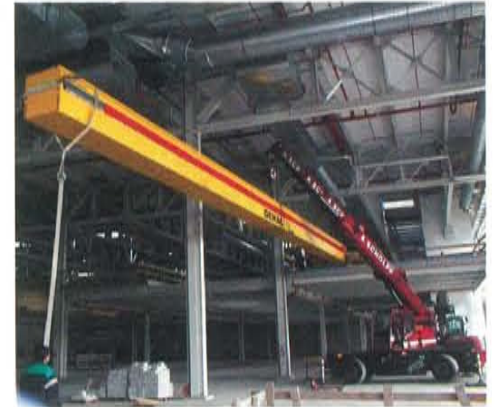
Der HK 30 beim abschließenden Einheben des Kranträgers.
