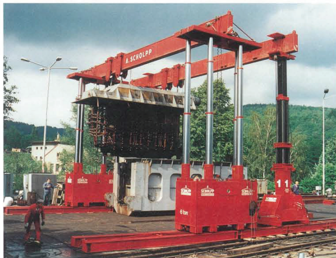
Hubgerüste TG 500 und TG 140 beim »Entkernen« eines Trafos, Gewicht 170 to.
