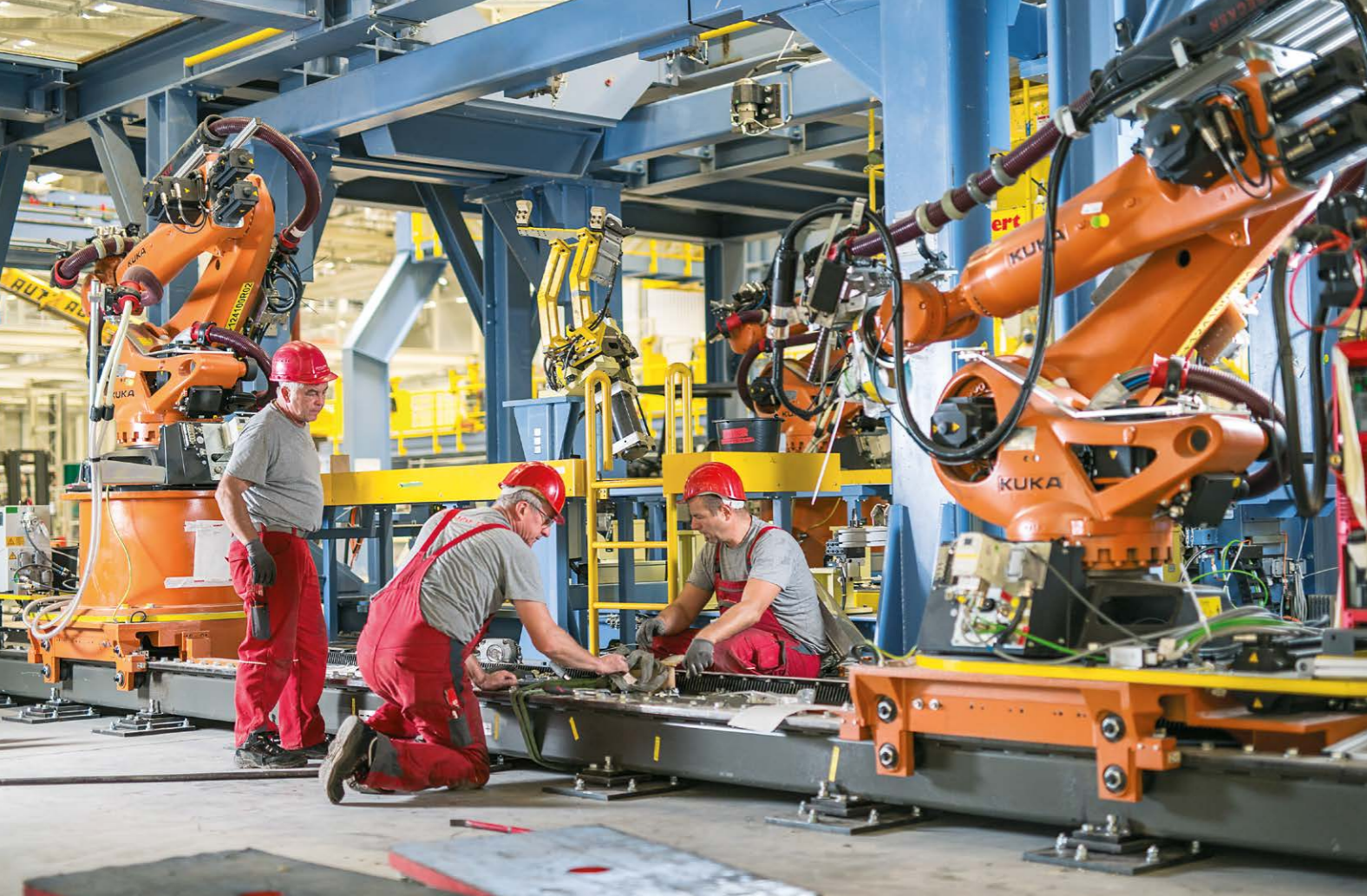
Effizienz in Inbetriebnahme setzt eine hohe Präzision bei der Aufbaumontage mit erlaubten Toleranzen im Hundertstelmillimeter-Bereich voraus.
